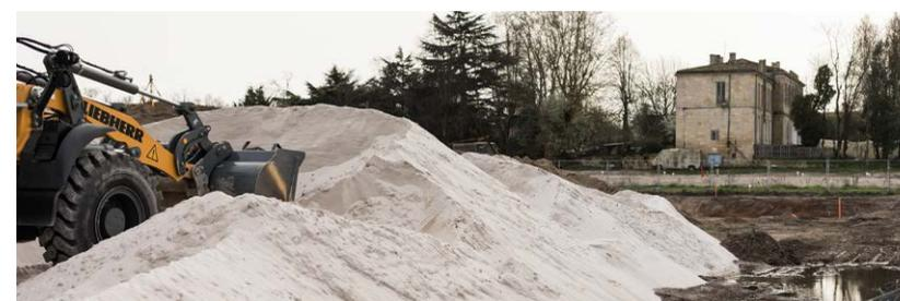
Un lit de sable a ensuite été posé, qui nous permet d'éviter l'eau stagnante, mais surtout d'ajuster avec précision la pente nécessaire au fonctionnement des puits et de régler la position des tuyaux (7).
